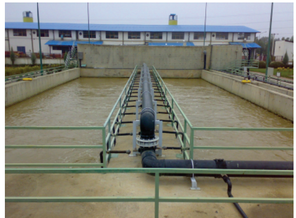
شکل ۱: واحد هوایی عمقی تصفیه خانه آق قلا
